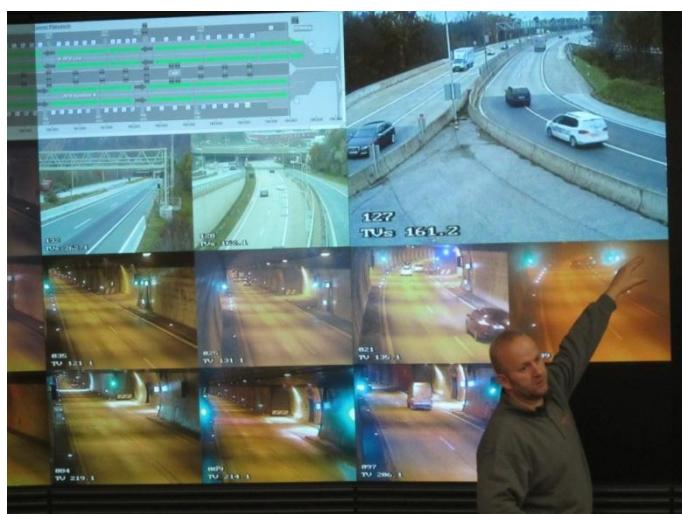
Tunel je u potpunosti pokriven nadglednim kamerama (ima ih više od 200 i mogu okretati za 360°) koje služe isključivo za nadzor (policija ih ne može koristiti za mjerjenje brzine vozila), svakih 225 metara nalaze se ugibališta s VoIP telefonima za hitne slučajeve, a svakih 500 metara nalaze se izlazi za slučaj opasnosti. U tunelu
